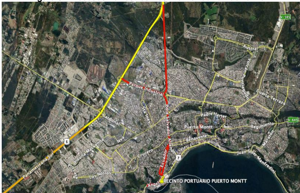
Figura 31. Accesos Terrestres Recinto Portuario Puerto Montt
